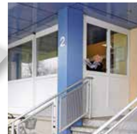
RIETH Györer Straße Besetzung im Haus 2 und Haus 6 erfolgt im wöchentlichen Wechsel.
