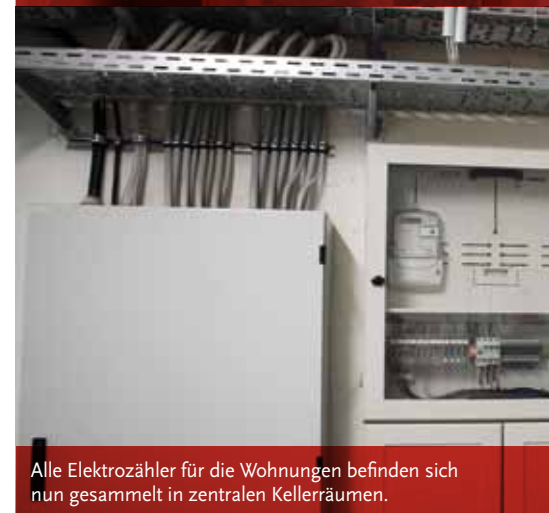
Neue Beleuchtung sowie Elektroleitungen wurden installiert.
