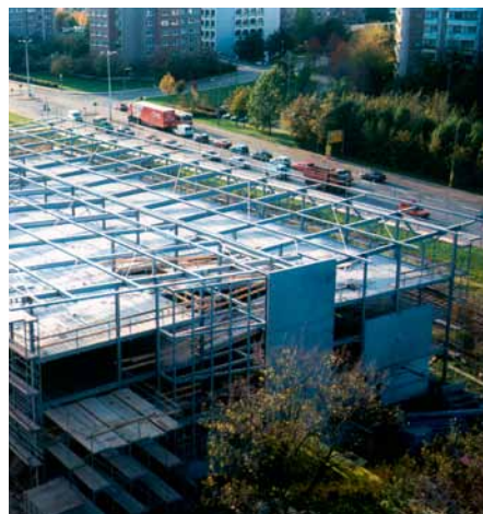
Bauphase des Parkhauses in der Hanoier Straße
