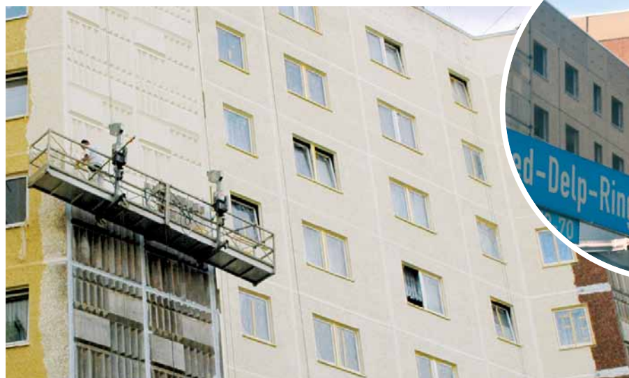
Sanierung in der Sofioter Straße
