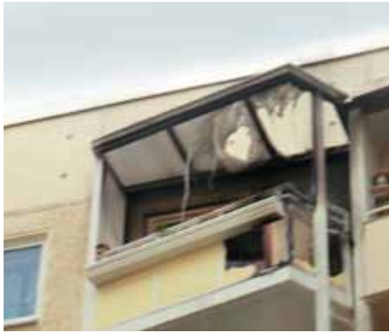
Kleine Ursache – verheerende Wirkung: das unsachgemäße Abbrennen von Feuerwerkskörpern setzte einen Balkon in Brand.
