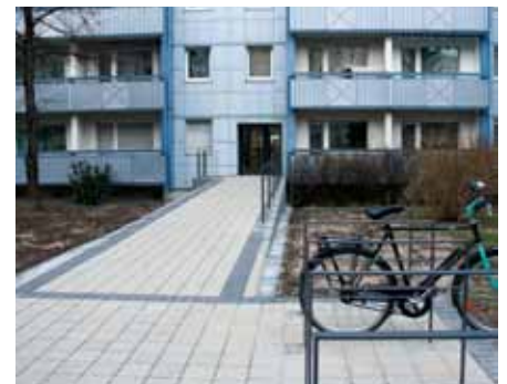
Hanoier Str. 1–3 - neuer Zugang am Hinterausgang mit Fahrradabstellplatz
