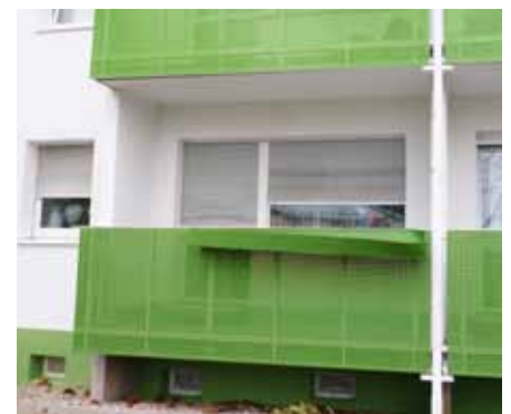
Mutwillige Zerstörung an der frisch sanierten Fassade in der Warschauer Straße
