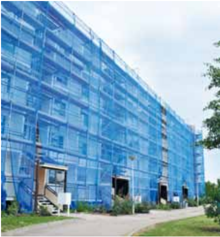
links: Am Alfred-Delp-Ring werden derzeit die Loggien erneuert.
