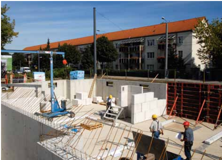
Die Baumaßnahmen in der Christian-Kittel-Straße schreiten voran.
