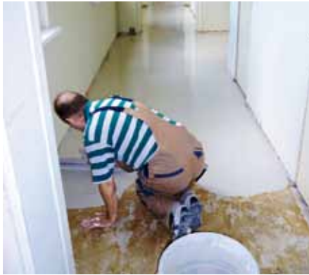
Julius-Leber-Ring – Erneuerung der Fußbodenbeläge
