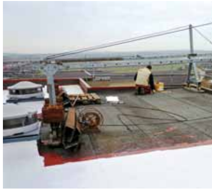
Neue Beschichtung des Flachdaches der Körnerstraße
